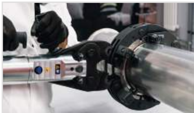
Assemblaggio pressatura n°1 / Press assembly phase 1
